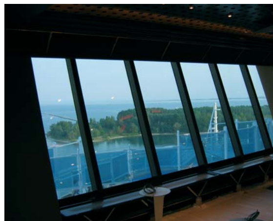
Doorkijkje in een van de vele bars waar gelamineerd glas is toegepast om redenen van doorvalbeveiliging.
